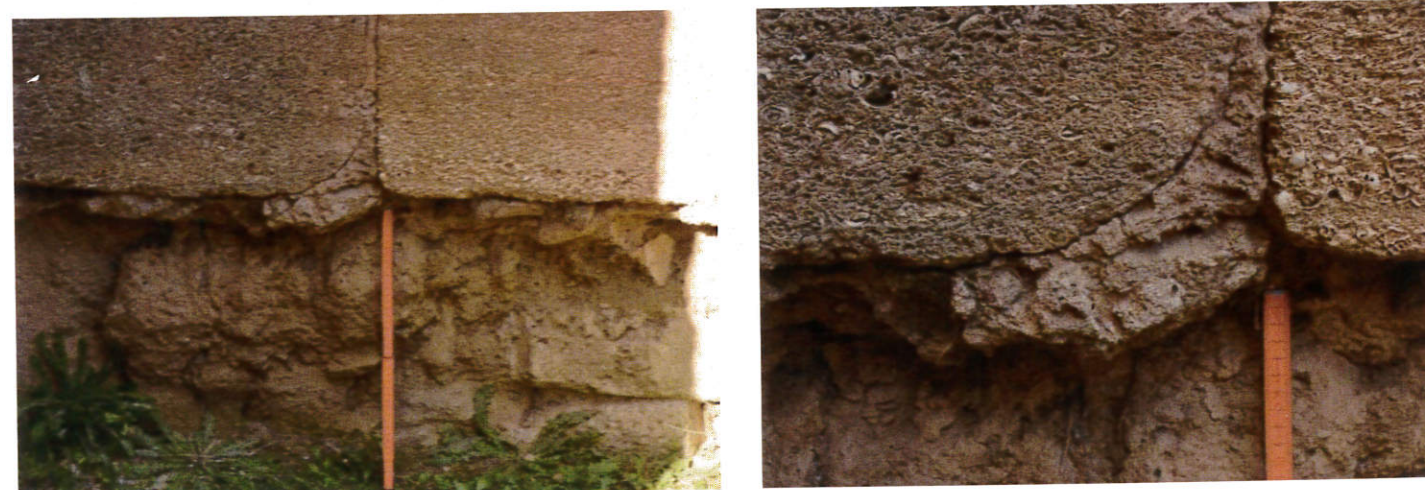
Εικ. 1 α, β. Θέση δειγματοληψίας, δείγμα 1, κωδ.OB1 (κονίαμα αρμολογήματος).
