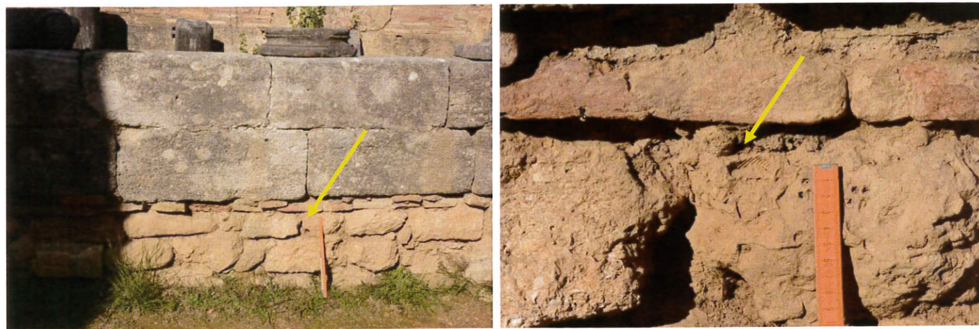
Εικ. 3 α, β. Θέση δειγματοληψίας, δείγματος OB3 (κονίαμα δομής/χωματολάσπη).
