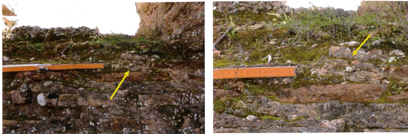
Εικ. 2 α, β. Θέση δειγματοληψίας, δείγμα 2, κωδ. OB2 (κονίαμα οπτοπλινθοδομής).
